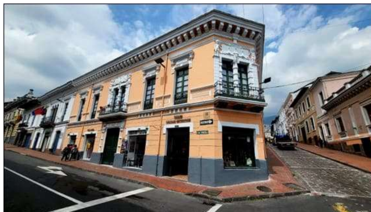
Figura 2: Edificación donde vivió la Dra. María Zúñiga en su etapa universitaria
