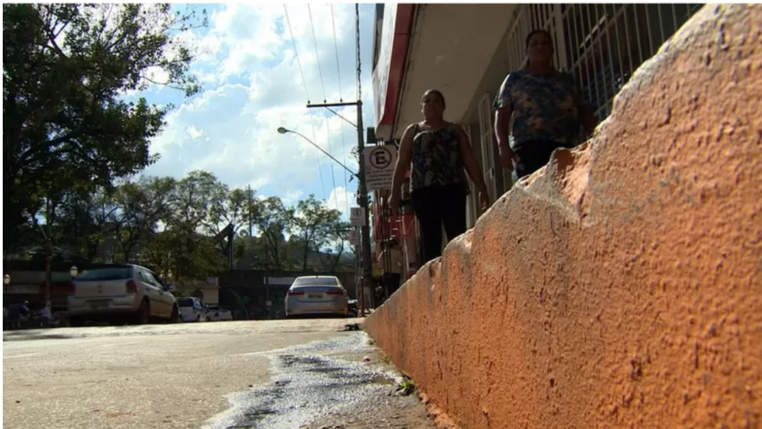
Figura 1 - Calçadas pintadas de laranja em Barão de Cocais, indicando mancha de inundação
