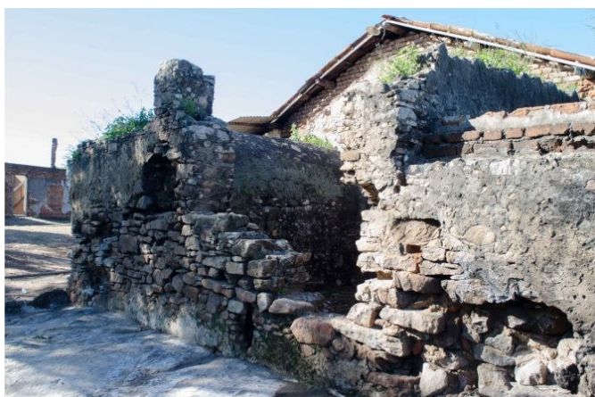
Figura 3: Ruína da "Maternidade de escravos", na antiga Fazenda Tanques. Fonte: Paraíba Criativa, 2023
