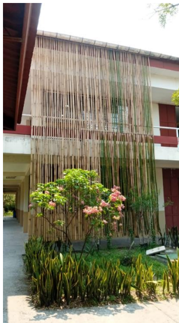
Figura 1. Barrera térmica de 12 metros de alto por 5 metros de ancho, conformada por una serie de bambúes apilados en las afueras del salón objeto de estudio.
