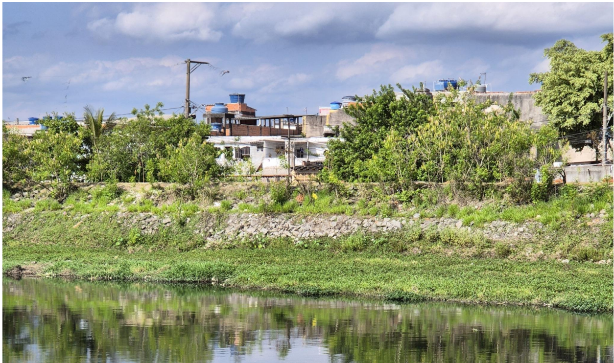
Figura 1 — Muro de gabião construído às margens do Rio Tietê, em outra comunidade próxima
