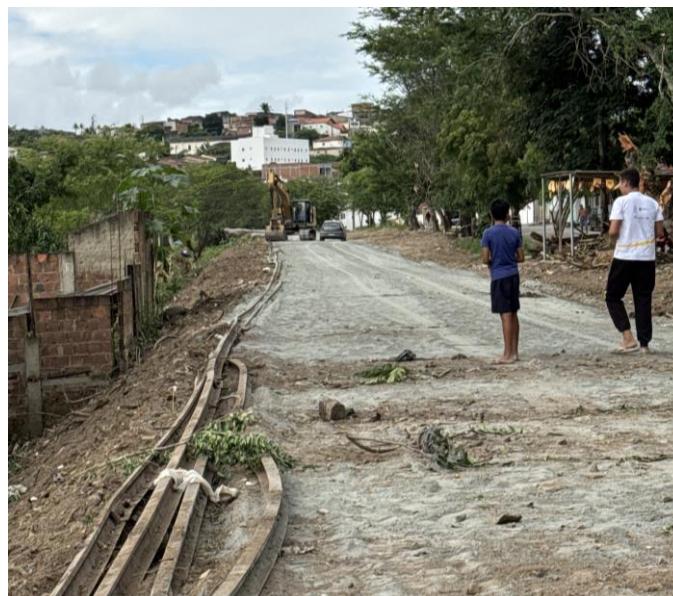
IMAGEM 01 – Movimentação de terras próxima às moradias no bairro do Araxá
