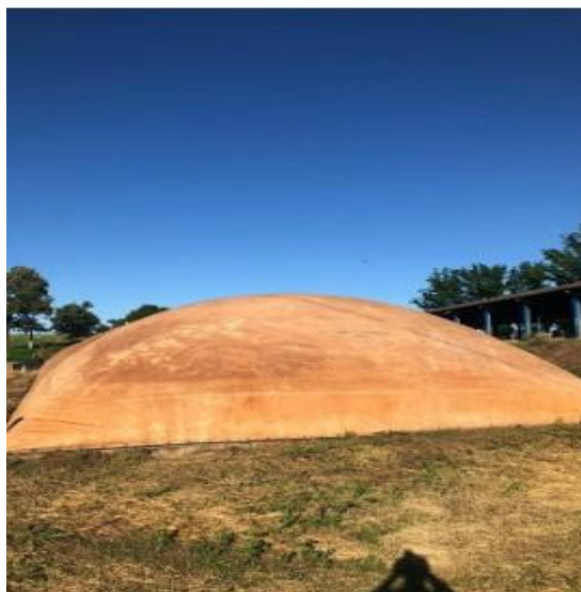
Figura 2: Biodigestor de manta
