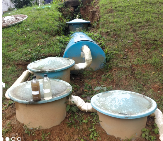
Figura 04 – Instalação da ETE.
