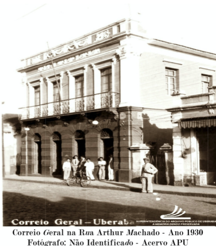
FIGURA 4 – Correio Geral de Uberaba-MG localizado na Rua Arthur Machado em foto de 1930.
