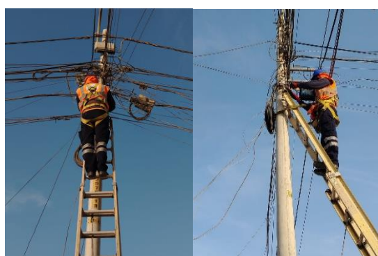
Figura 6. Trabajo en altura post aplicación.
