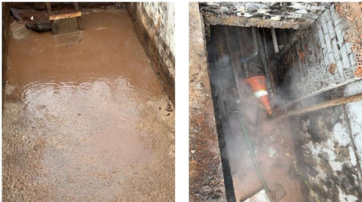
Figura 6. Liberação de gases e vapores observada no início do processo de remediação. Fonte: Autores, 2025.
