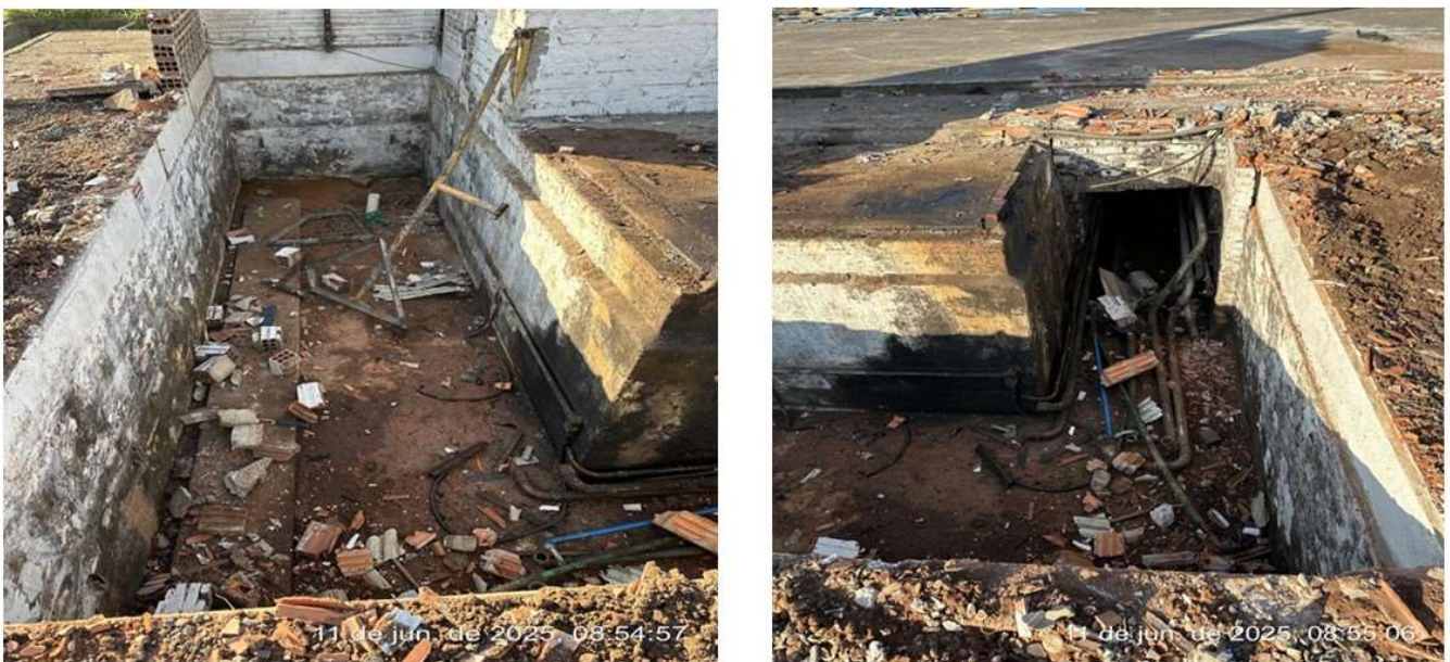
Figura 3. Trincheira onde foi realizada a remediação por Fenton Heterogêneo. Fonte: Autores, 2025.
