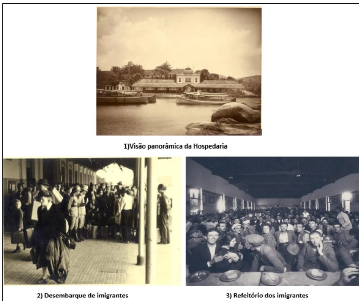
Figura 5 – A Hospedaria da Ilha das Flores - Neves/São Gonçalo/RJ
