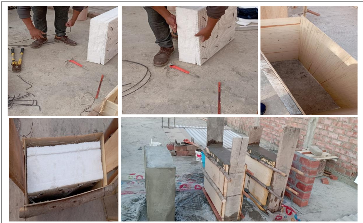
Fig. 4. Se hizo 3 murete de Tecnopor.
