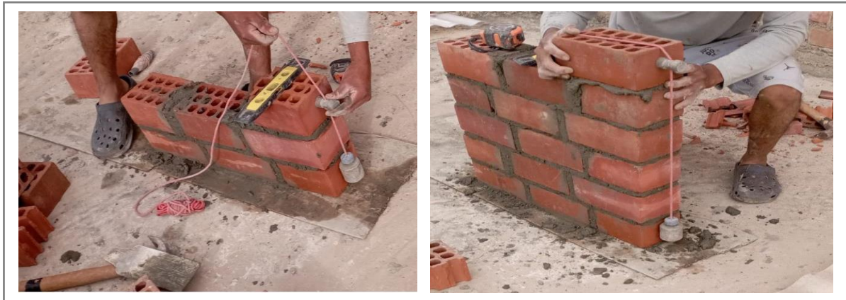
Fig. 3. Se hizo un murete de ladrillo.
